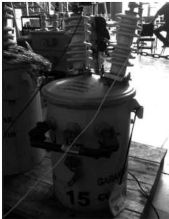
Figura 11. Transformador de distribución monofásica (piloto).
