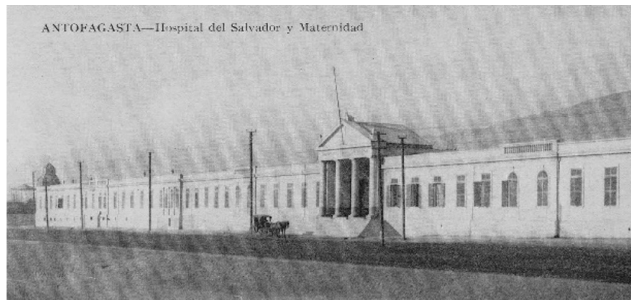
Fig. 7. Fachada del Hospital del Salvador, Antofagasta, 1890.
