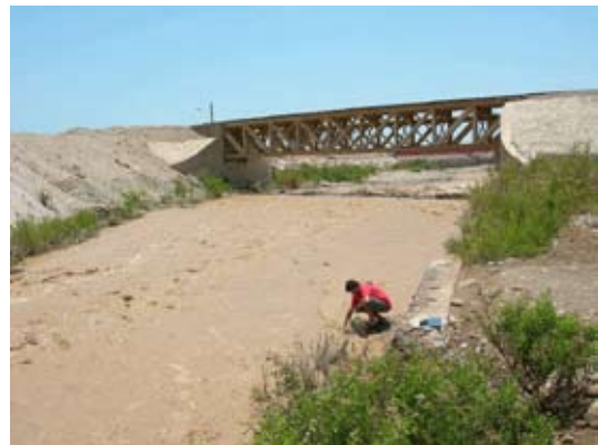
Figura 10. Estación N° 7 de Muestreo. Sector Puente Ferroviario, río Lluta.
