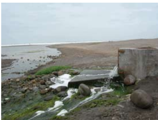
Figura 1. Descarga Agua Descarte Desalari.
