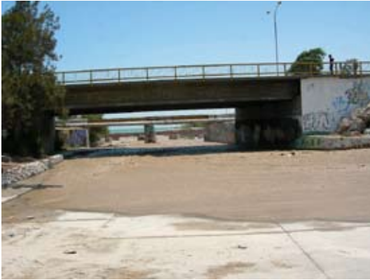
Figura 5. Estación N° 3 de Muestreo. Sector Puente Ferroviario. río San José.
