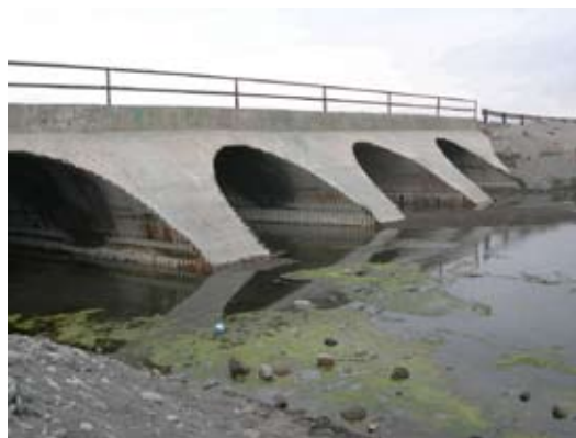
Figura 12. Sector Puente Desembocadura, río Lluta sin bajada del río.
