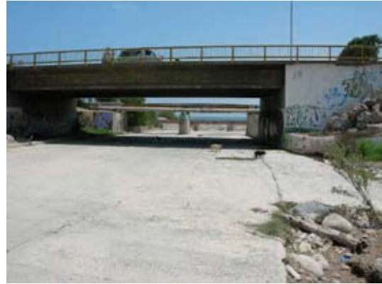
Figura 6. Sector Puente Ferroviario: río San José, sin bajada del río.
